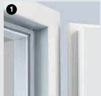
1 Eckzarge mit umlaufender Dichtung
